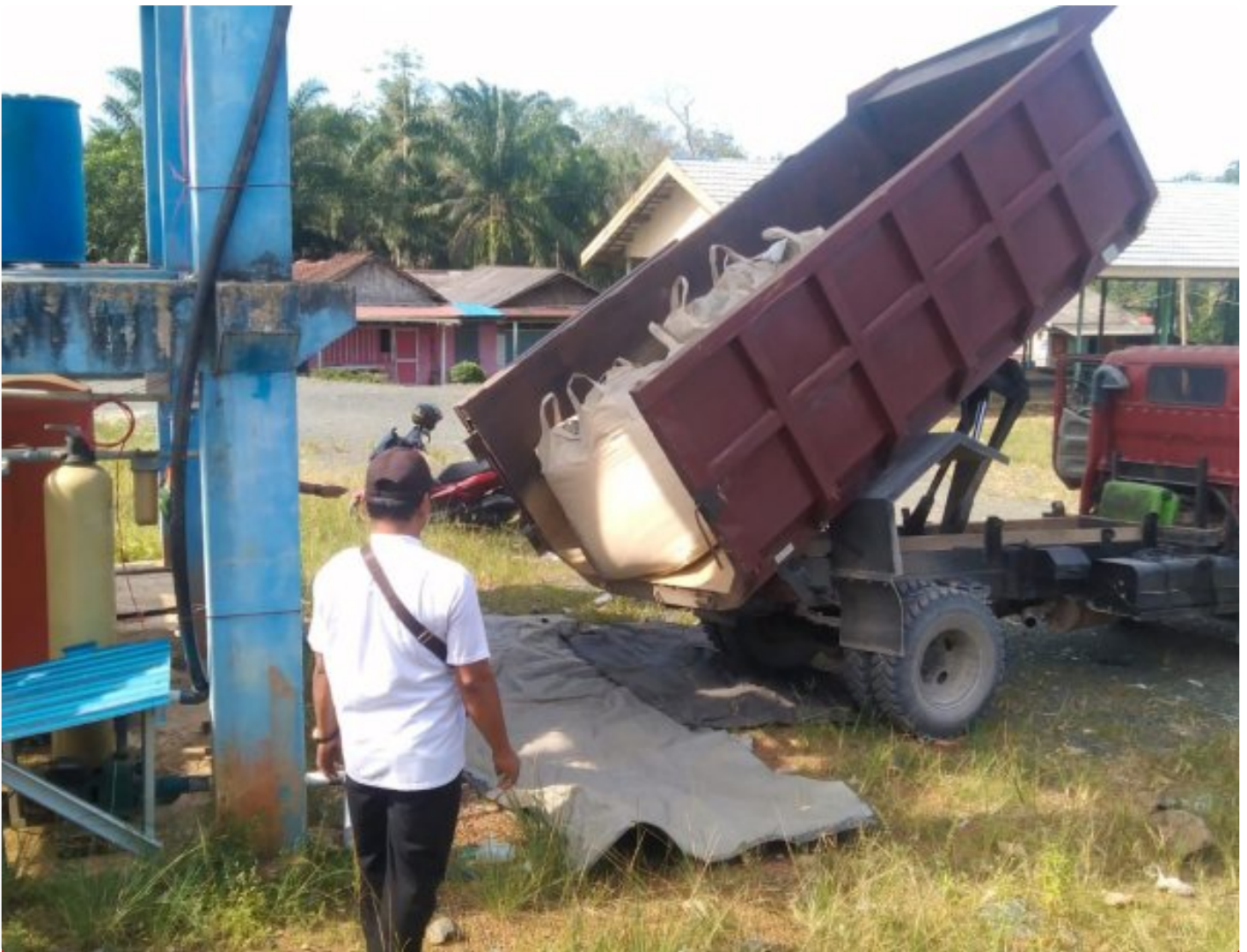
Kodim 1004/Kotabaru Datangkan Material Di Lokasi TMMD Ke 116
